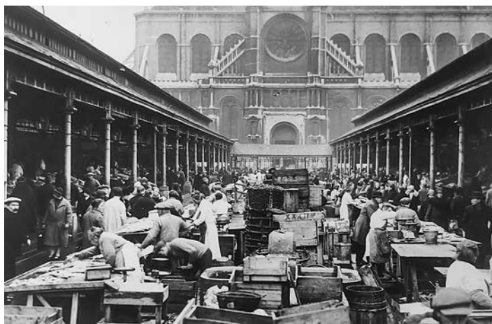
Les étals du marché au poisson, protégés par des auvents.
