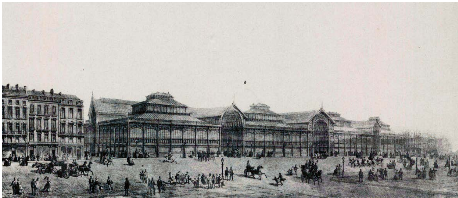
Les Halles centrales.
