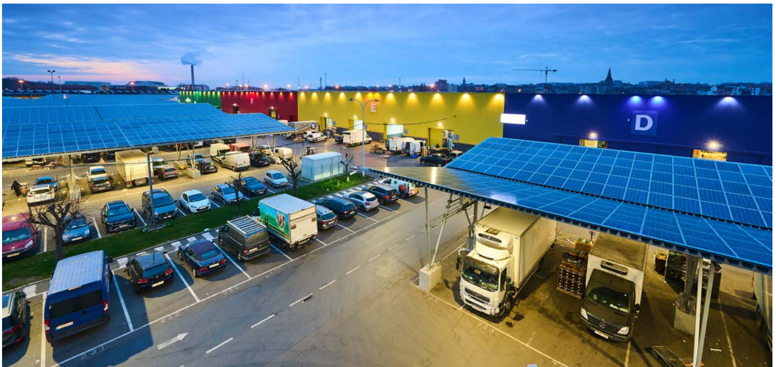
En 2017, une fois écartée la menace de déménagement, les façades des halles ont été rénovées et ont reçu un nouveau bardage de couleur. Toen in 2017 de dreigende verhuizing was afgewend, werden de gevels van de hallen gerenoveerd en voorzien van een nieuwe gekleurde bekleding.
